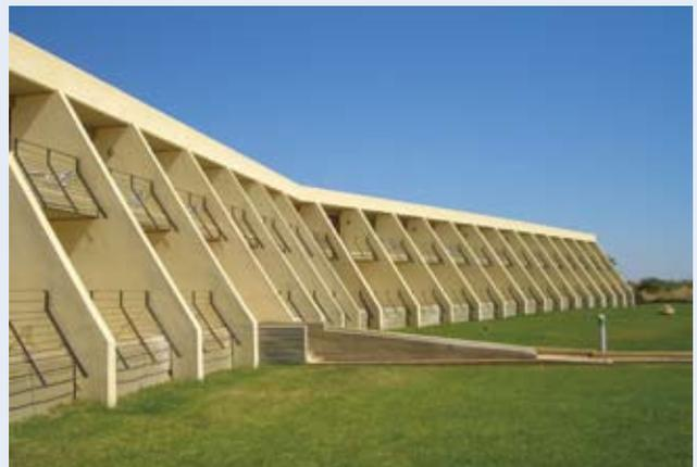
巧妙的垂直板外觀不僅配合建築外觀設計，也能有效阻擋太陽直射熱，減少室內空調的耗電量。
